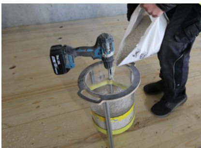
1/2 Sack Schüttung einfüllen
