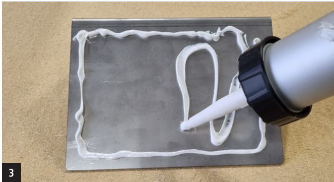
3 FDM WALL auf den Winkel auftragen und rückseitig der STURZBLENDE andrücken (Abstände siehe Verarbeitungsrichtlinie)
