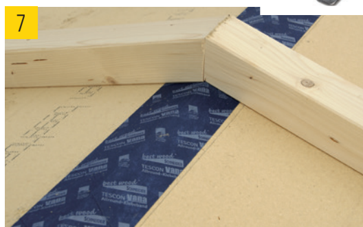
(7) Firstanschluss abgeklebt und Holzfaserplatten mit Konterlatten befestigt.
