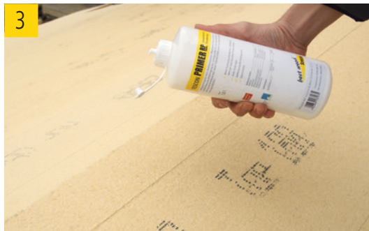
(3) TESCON PRIMER RP mit Pinsel (4) oder Auftragswerkzeug TENAPP (5) in Klebebandbreite auf die TOP auftragen.
