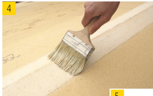
(3) TESCON PRIMER RP mit Pinsel (4) oder Auftragswerkzeug TENAPP (5) in Klebebandbreite auf die TOP auftragen.
