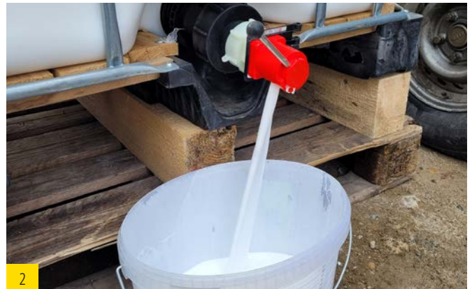
2 Ein Unterbau des IBCs mit drei Europaletten oder entsprechenden Kanthölzern ermöglicht eine einfache Entnahme des Bindemittels. Der rote Dosierhahn ist im Lieferumfang nicht enthalten. Er ist entweder bauseits zu stellen oder muss separat bestellt werden.
