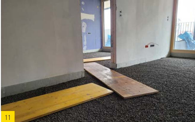
11 Wird es notwendig die Schüttungsebene vor dem Ende der Trocknungszeit (frühestens ab dem dritten Tag) dauerhaft zu begehen, muss diese mit Plattenmaterial z.B. Schaal-tafeln abgedeckt werden.
