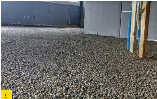
9 Eingebraachte und abgezogene Schüttung. Während des Abbindens darf diese nicht betreten werden. Nach dem Abbinden stellt die Schüttung keine Lauffläche dar. Sie darf nur zum Verlegen der Trittschalldämmung betreten werden.
