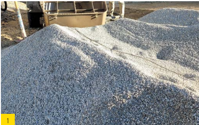
1 Lieferung des Splitts auf die Baustelle. Dieser darf maximal erdfeucht sein und ist vor Regen und hoher Feuchtigkeit zu schützen
