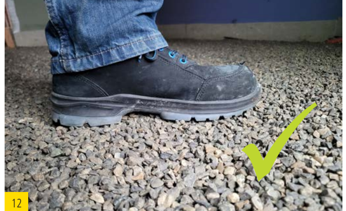
12 Nach ausreichender Trocknung dürfen beim Begehen der Fläche keine Fußabdrücke entstehen.
