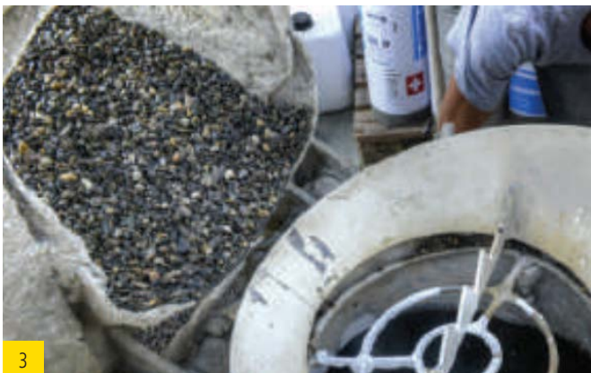
3 Anmischen des Estrichs in der Estrichpumpe. Je m^3 Splitt (Körnung 5/8) werden 30kg Bindemittel benötigt.
