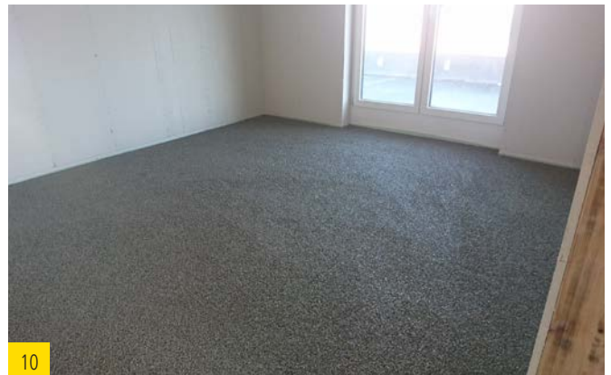
9 Eingebraachte und abgezogene Schüttung. Während des Abbindens darf diese nicht betreten werden. Nach dem Abbinden stellt die Schüttung keine Lauffläche dar. Sie darf nur zum Verlegen der Trittschalldämmung betreten werden.
