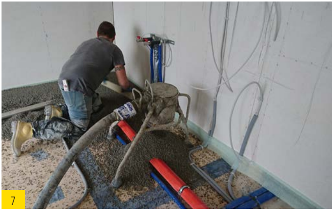
7 Befördern des angemischten Splitts und grobes Verteilen mittels Estrichpumpe.
