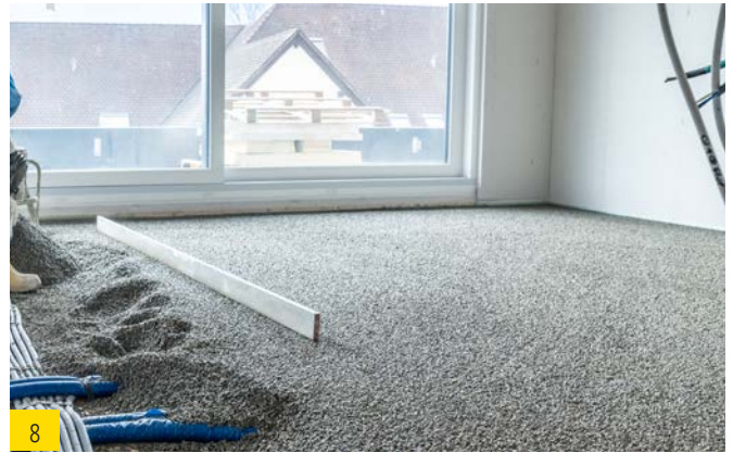
8 Abziehen des Splitts mittels Setzlatte auf die gewünschte Schütthöhe.
