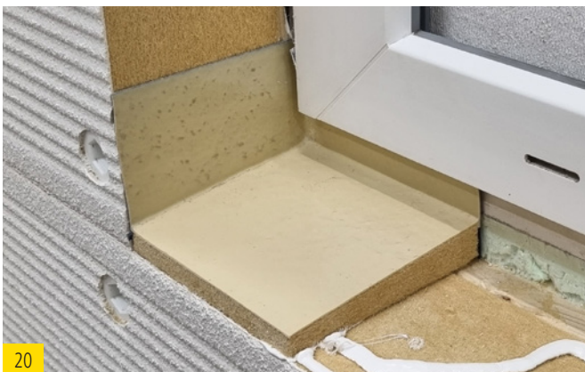
20 Wichtig: Sicherstellen, dass es zwischen dem Fensterrahmen und der Holzfaserplatte wieder ein "U" bildet (siehe Bild Nr. 10)
