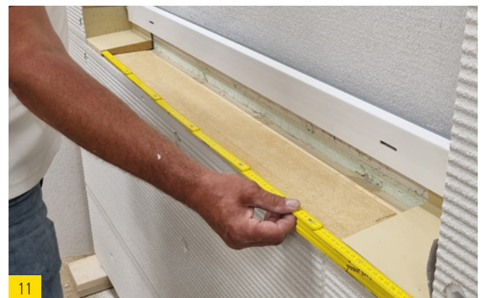
Den Zwischenraum von Dichtecke links zu rechts ausmessen und den Dichtkeil (Mittelteil) in richtiger Länge zuschneiden.
