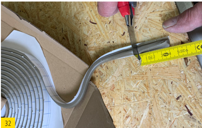
32 4 cm der Dichtschnur abschneiden.
