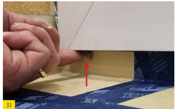
33 Die Dichtschnur in die Ecken unterhalb des Fensterrahmens in den Hohlraum kleben damit dieser verschlossen ist.
