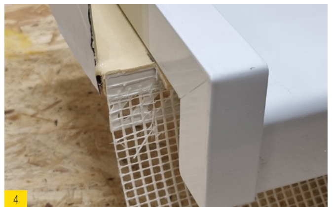
4 Putzabschlussprofil und Fensterbank auf gleicher Länge.
