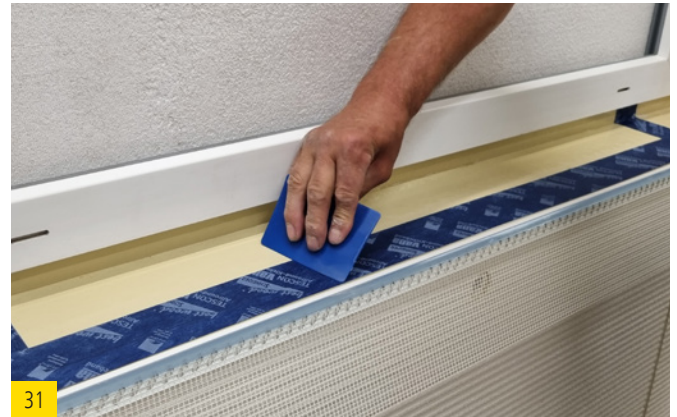
31 Klebeband mit einer Rakel glattstreichen.
