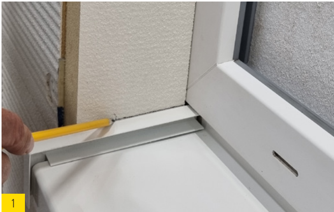
1 Ausklinken der 40 mm Laibungsplatte.
