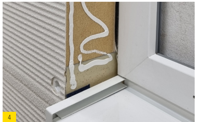
4 best wood FDM WALL seitlich auftragen.
