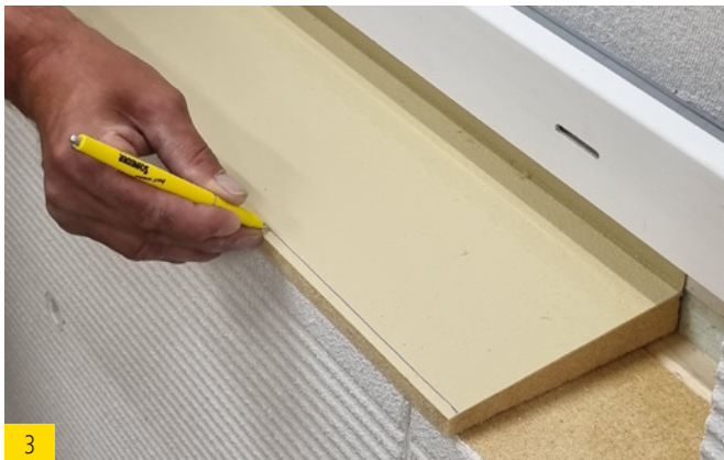
3 Dichtkeil mit entsprechender Tiefe anzeichnen.
