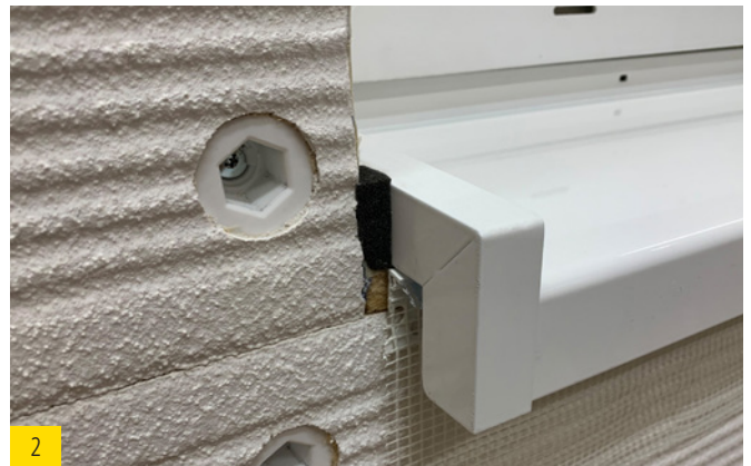
2 Fensterbank montieren. Fensterbankendstück und Putzabschlussprofil müssen bündig sein. Fugendichtband auf Fensterbankendstück aufbringen.
