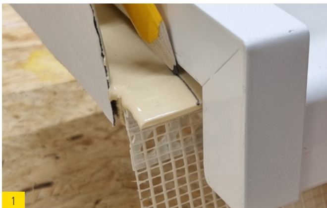
1 Fensterbanklänge auf rechtem und linkem Dichtkeil anzeichnen.
