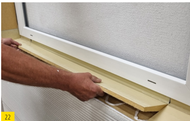
22 Den Dichtkeil zwischen den Ecken passgenau eindrücken
