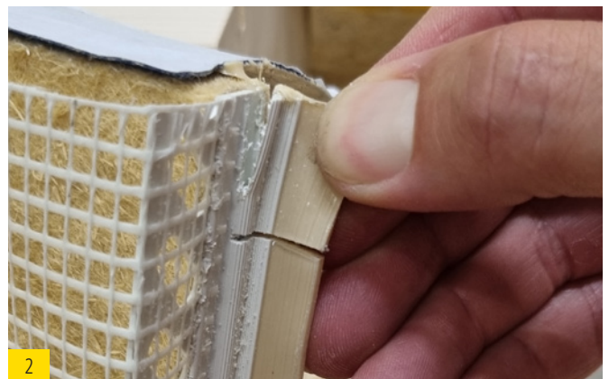
2 Putzabschlussprofil inkl. Gewebesteg auf angezeichnete Länge kürzen.
