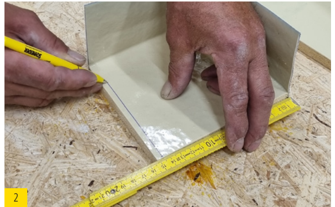
2 Dichtecke mit entsprechender Tiefe anzeichnen.
