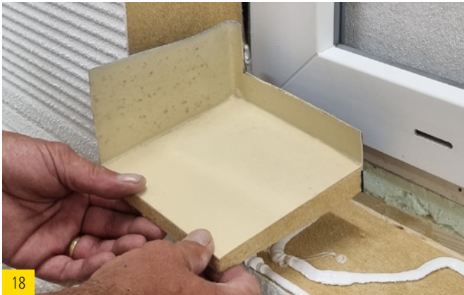
18 Die Dichtecken in beide Ecken positionieren
