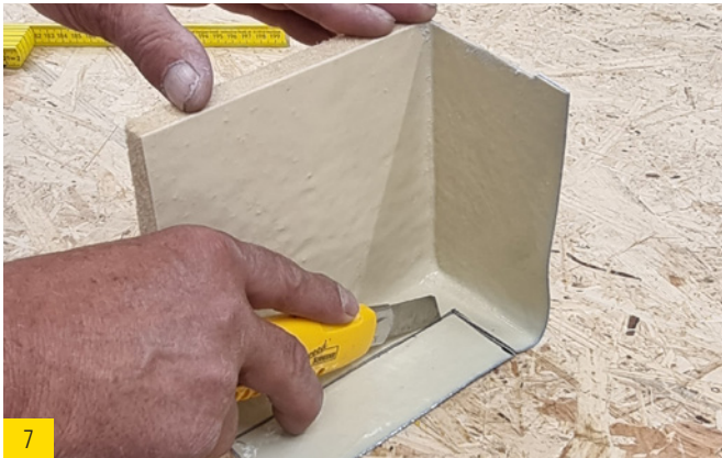
Die Dichtecken an die Fensterecken anpassen.
