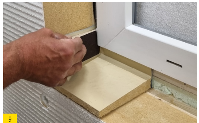
Beide Eckteile einlegen und mit einem Hilfsmittel (z. B. Holzkeil) sauber in die Ecke der Fensterbank eindrücken.
