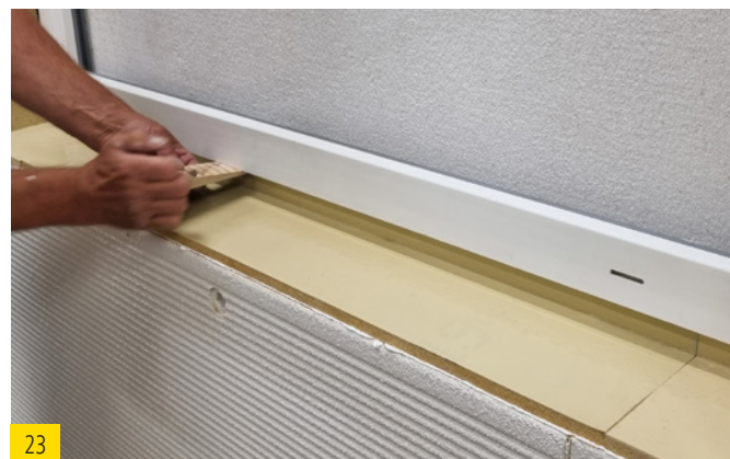
23 Unterhalb des Fensterrahmens ebenfalls mit einem Hilfsmittel (bspw. Holzkeil) den Klebestreifen fest andrücken
