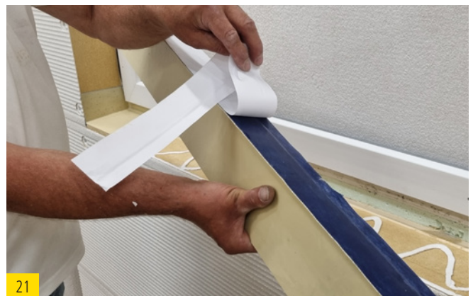
21 Das Klebeband des bereits zugesägte Dichtkeils abziehen
