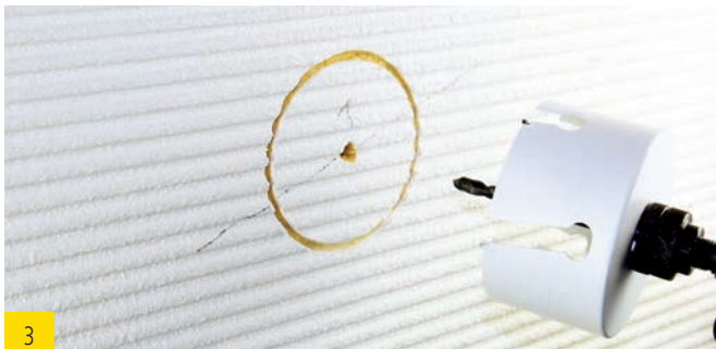
1 Einblasöffnung anzeichnen und nummerieren
