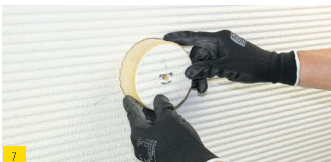
5 Bohrstopfen entnehmen
