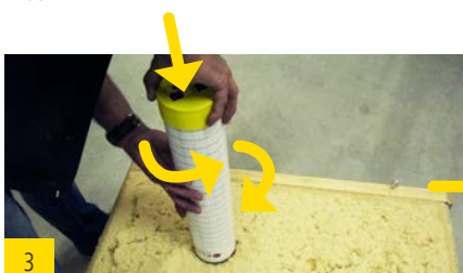
3 Prüfrohr vorsichtig, mit geringem Druck in Dämmmaterial eindrehen
