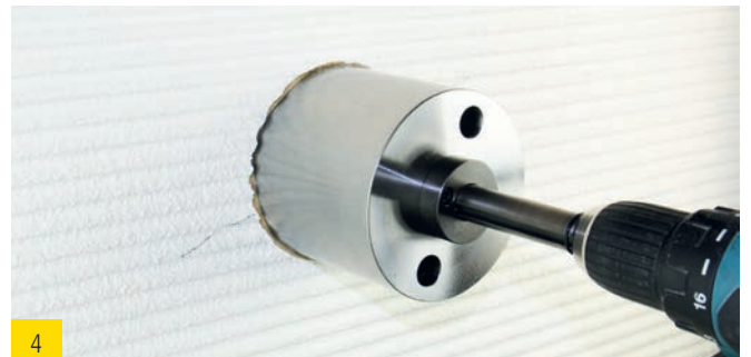
2 mit Lochsäge LH Putzschicht vorbohren
