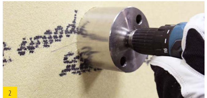
2 Öffnung mit Lochsäge (ED) herstellen
