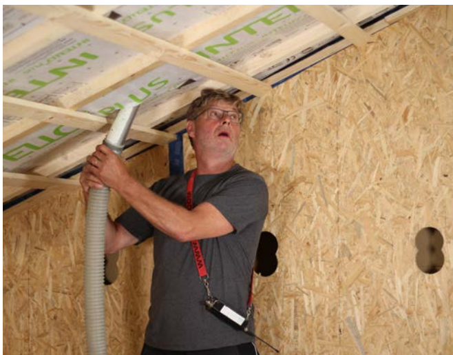
Dachkonstruktion mit Nadel 65 Ø verfüllen.
