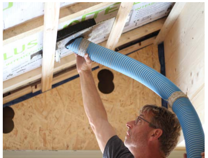
Dachkonstruktion mit Schlauchverfahren verfüllen.
