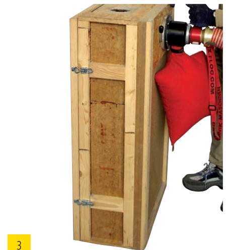
3 Verdichtetes Einblasen mit entlüfteter Drehdüse
