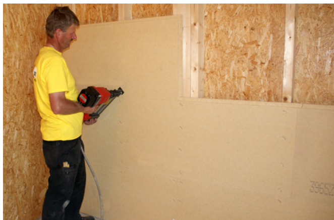
Befestigung mit Breitrückenklammern.
