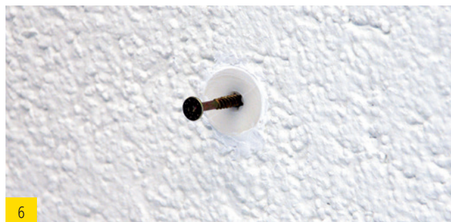
6 Mit 4–5 mm-Schraube Anbauteil befestigen.
