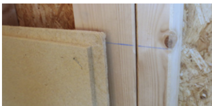
Erste Plattenreihe an waagrechter Schlagschnur ausrichten.
