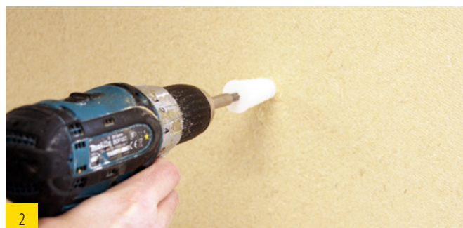
2 Spiraldübel mit TORX T40 in unverputzter Holzfaser-Dämmstoffplatte eindrehen.
