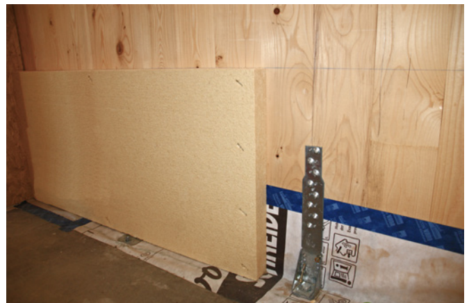
Erste Plattenreihe an waagrechter Schlagschnur ausrichten.
