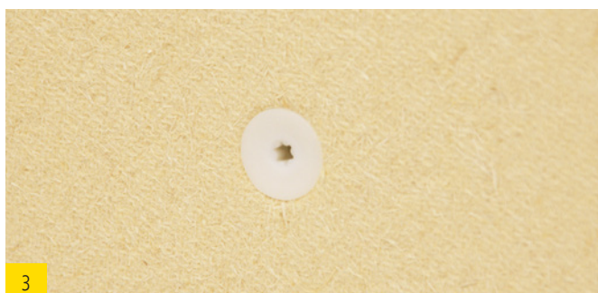
3 Schraubdübel oberflächenbündig montieren.
