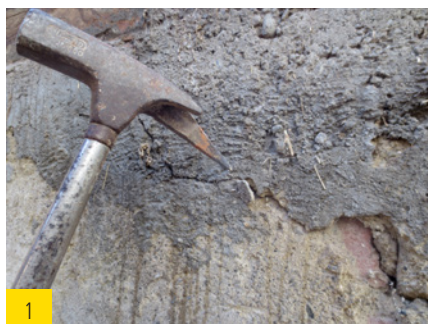
1 Lose Putzschichten entfernen.
