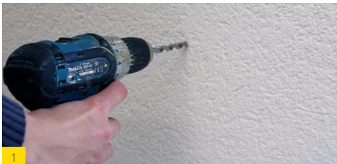
1 Verputzte Holzfaser-Dämmstoffplatte mit 8 mm-Holzbohrer vorbohren.
