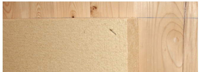
Erste Plattenreihe an waagrechter Schlagschnur ausrichten.
