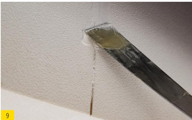
9 Bei offenen Fugen am Stoß müssen diese mit FDM WALL geschlossen werden.
