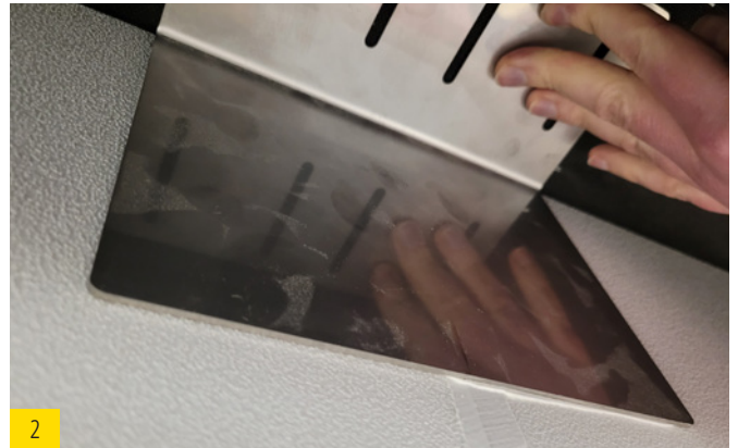
2 Winkel Rückseitig an die Sturzblende andrücken
