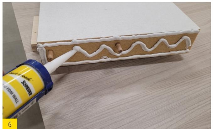
6 FDM WALL an der Stirnseite eines Elements auftragen und die Elemente miteinander verbinden.
