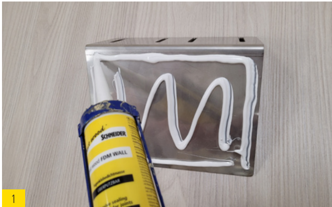
1 FDM WALL auf den Winkel auftragen. Für die Anzahl der Winkel siehe Tabelle
