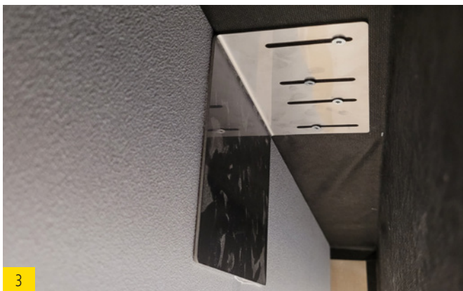
3 Winkel mit 4 Schrauben 4,5 x 40 im Riegel verschrauben
