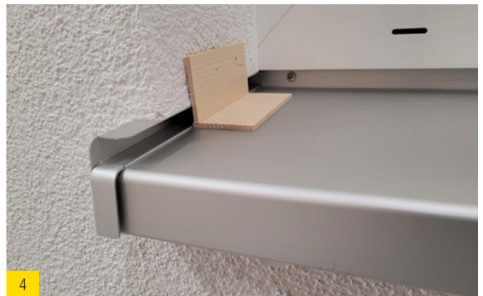
4 Tipp: Für den gleichmäßigen Abstand zur Fensterbank Unterlegmaterial mit 5 mm verwenden (identisch zur Detailzeichnung und Bestellung).
