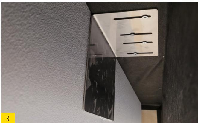
3 Winkel mit 4 Schrauben 4,5 x 40 im Riegel verschrauben
