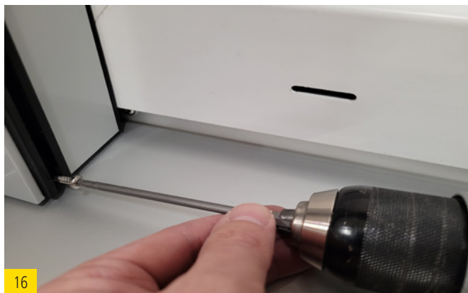
14 Den Raffstore in der Breite ausrichten und die Schrauben am Träger leicht anziehen.
