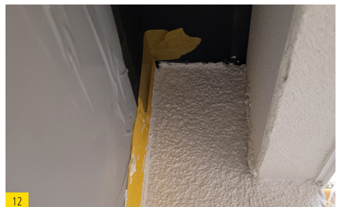
10 Beim Einspachteln des Tropfkantenprofils das Gewebe an der Unterseite so abschneiden, dass es nicht über die STURZBLENDE übersteht. Der Stoß der STURZBLENDE und der Stoß des Tropfkantenprofils muss versetzt sein.
