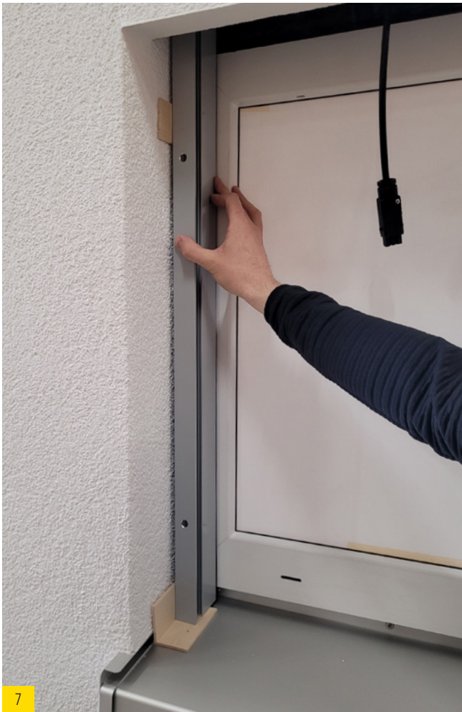
7 Die Führungsschienen senkrecht und parallel ausrichten.
