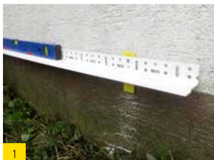
1 Sockelprofil waagrecht ausrichten und befestigen.
