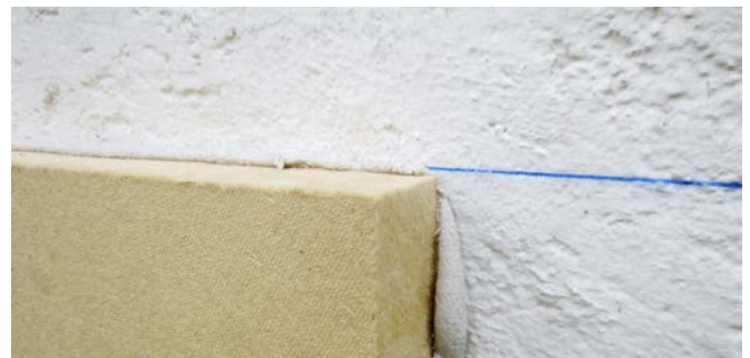
WALL 140 an waagerechter Schlagschnur ausrichten.
