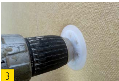
3 Dübel oberflächenbündig anziehen.
