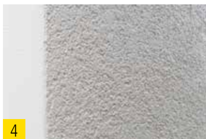
Fertig strukturierte Putzfläche.
