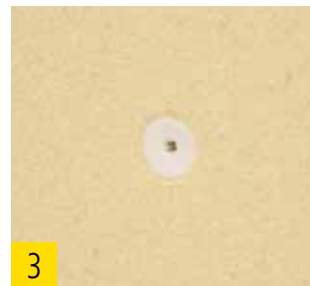
3 Schraubdübel oberflächenbündig montieren.
