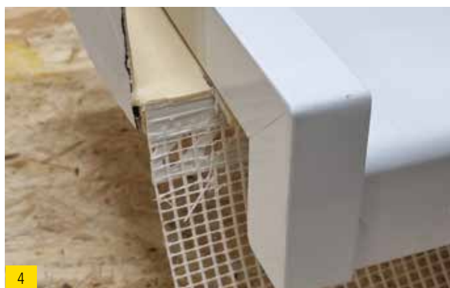
Putzabschlussprofil und Fensterbank auf gleicher Länge.
