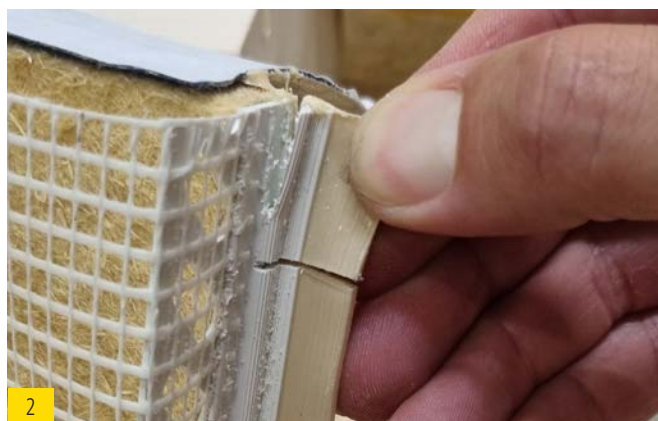
Putzabschlussprofil inkl. Gewebesteg auf angezeichnete Länge kürzen.
