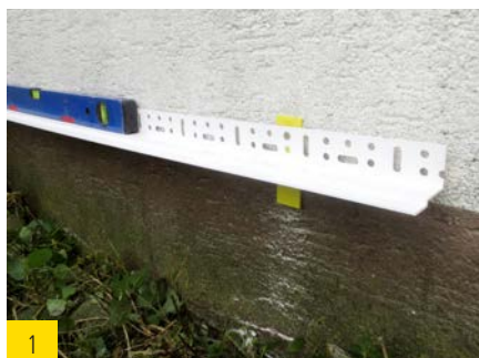
1 Sockelprofil waagrecht ausrichten und befestigen.
