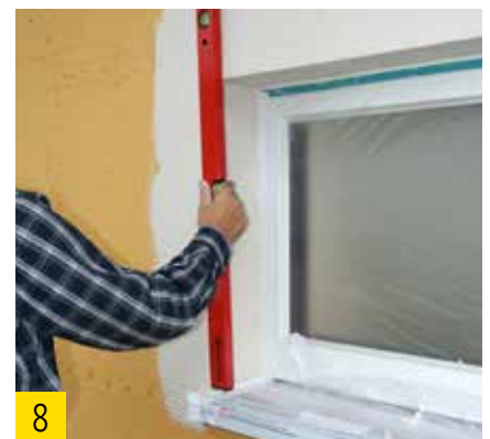
7 Gewebeeckwinkel horizontal und vertikal ausrichten.
