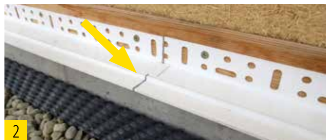
2 Stoßverbinder an den Längsstößen einbauen.
