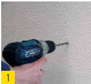
1 Verputzte Holzfaser-Dämmstoffplatte mit 8 mm-Holzbohrer vorbohren.
