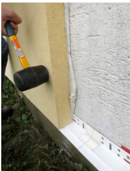
WALL 140 vollflächig auf Sockelschiene aufstellen.
