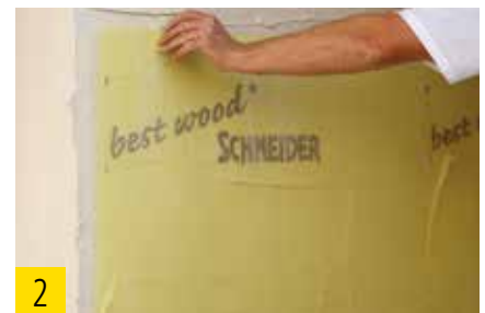
2 best wood Armierungsgewebe einlegen.
