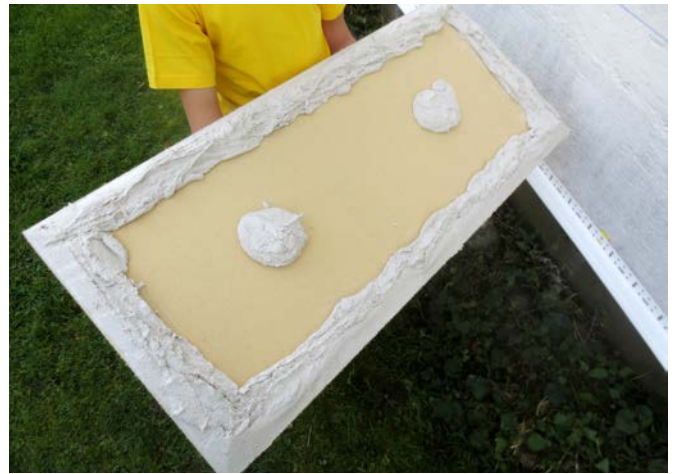
Auftrag Punkt-Wulst-Verfahren.
