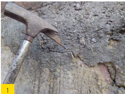
1 Lose Putzschichten entfernen.
