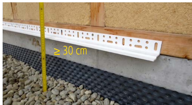
Spritzwasserzone \geq 30 cm ohne zusätzliche Maßnahme.
