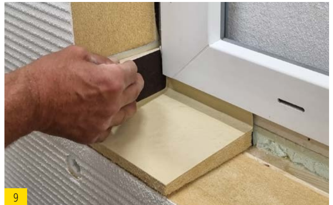
Beide Eckteile einlegen und mit einem Hilfsmittel (z. B. Holzkeil) sauber in die Ecke der Fensterbank eindrücken.
