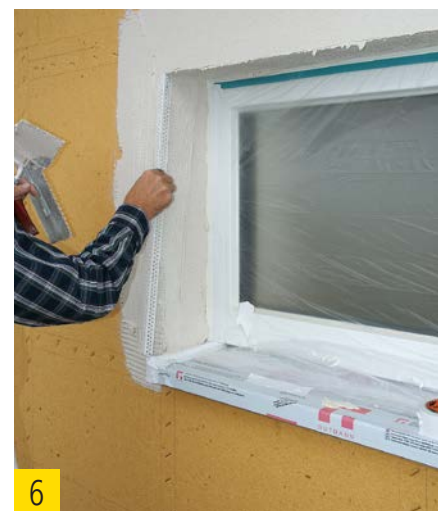
Gewebeeckwinkel einsetzen.
