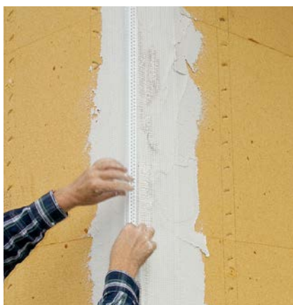
Gewebeeckwinkel einsetzen.
