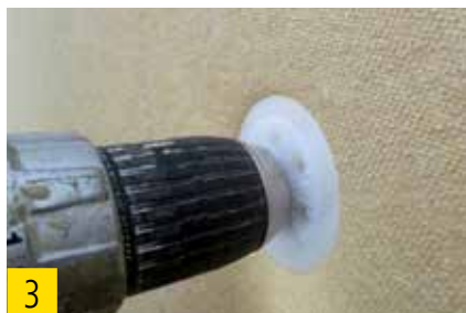
3 Dübel oberflächenbündig anziehen.
