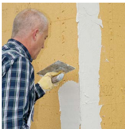
Klebe- und Armierungsmörtel (UP) aufziehen.
