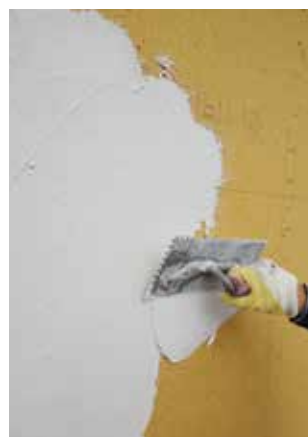
Klebe- und Armierungsmörtel (UP) aufbringen.
