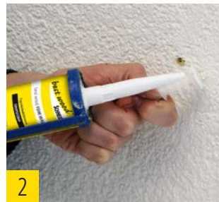
2 best wood FDM WALL unter Dübelteller auftragen.
