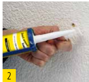
2 best wood FDM WALL unter Dübelteller auftragen.
