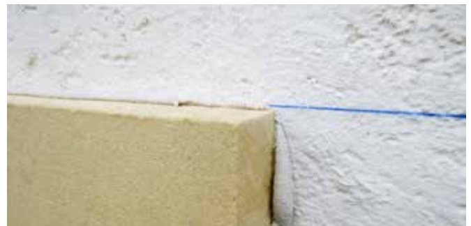
WALL 140 an waagerechter Schlagschnur ausrichten.
