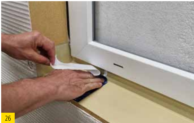
Denselben Stoß mit einem Streifen TESCON VANA überkleben.
