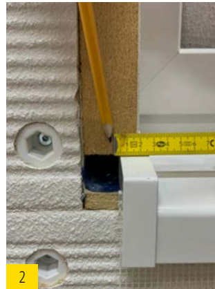
2 20 mm anzeichnen und markieren was ausgesägt werden soll.
