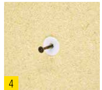
4 Mit 4–5 mm Schraube Anbauteil befestigen.
