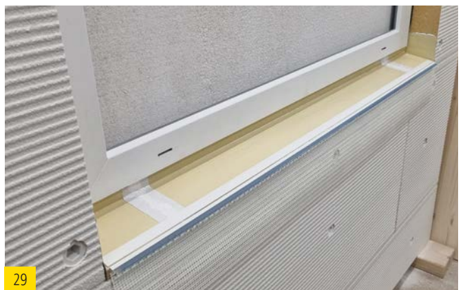
best wood Putzabschlussprofil ausgemittelt zwischen den Laibungen anbringen.
