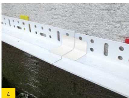
4 Stoß mit Klebeband abkleben.
