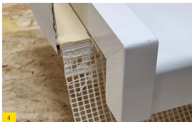
Putzabschlussprofil und Fensterbank auf gleicher Länge.
