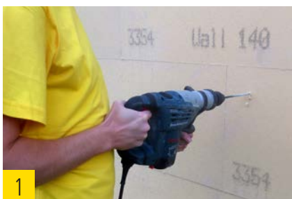
1 Vorbohren mit Schlagbohrmaschine.
