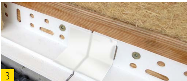
3 Stoß mit Kleband abkleben.
