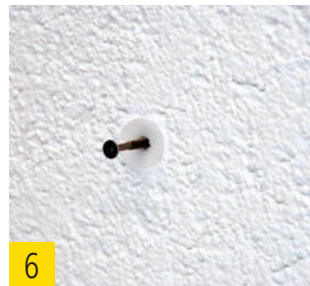
6 Mit 4–5 mm Schraube Anbauteil befestigen.
