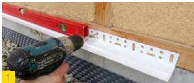
1 Sockelprofil waagrecht ausrichten und befestigen.
