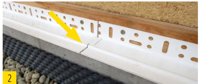
2 Stoßverbinder an den Längsstößen einbauen.
