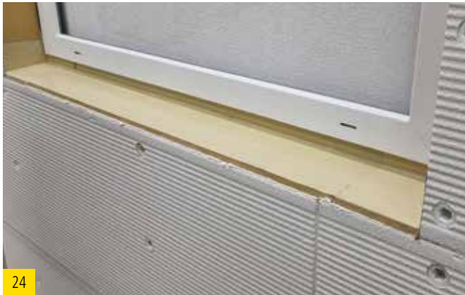
Fertig verklebte und eingepasste Dichtebene wird nun an den Stoßfugen abgedichtet und das Putzabschlussprofil angebracht.
