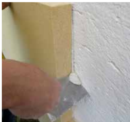
Seitlich austretendem Kleber entfernen.
