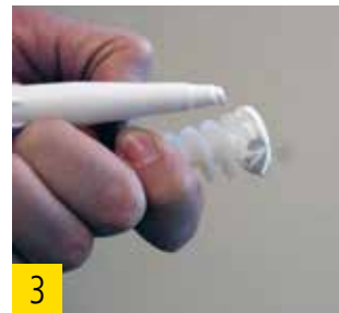
3 best wood FDM WALL zur Abdichtung verwenden.
