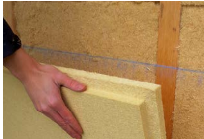
Erste Plattenreihe an waagrechter Schlagschnur ausrichten.
