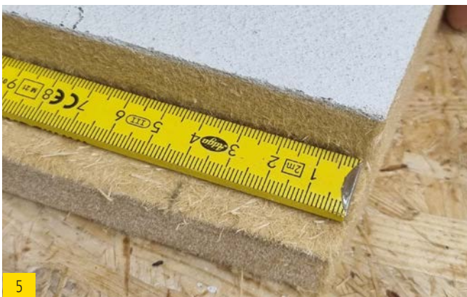
5 40 mm abmessen für das Ausklinken der hinteren Ecke am Fenster.
