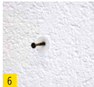
6 Mit 4–5 mm Schraube Anbauteil befestigen.
