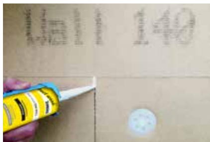
Verlegefugen mit FDM WALL schließen.
