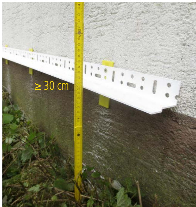
Spritzwasserzone \geq 30 cm ohne zusätzliche Maßnahme.
