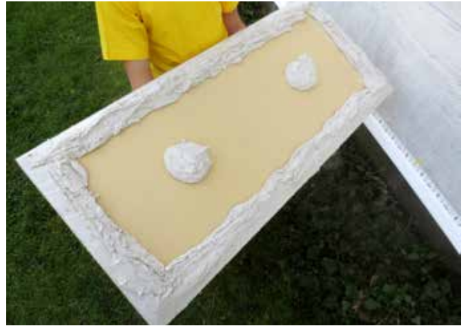
Auftrag Punkt-Wulst-Verfahren.
