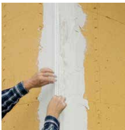
Gewebeeckwinkel einsetzen.
