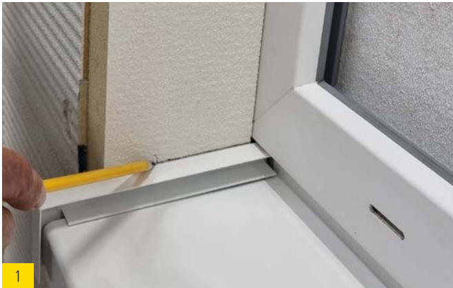
1 Ausklinken der 40 mm Laibungsplatte.
