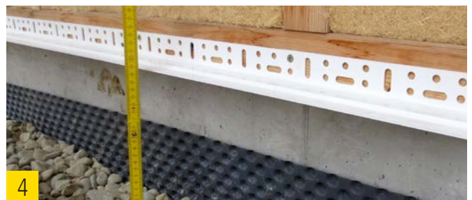
4 Spritzwasserzone \geq 30 cm ohne zusätzliche Maßnahme.
