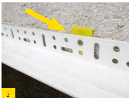
2 Distanzausgleich an Sockelschiene.
