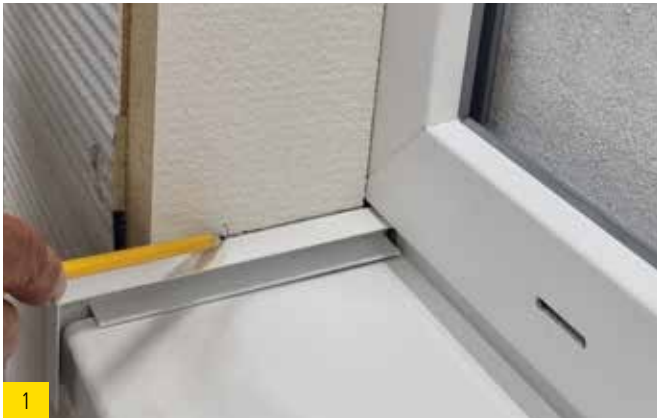
1 Ausklinken der 40 mm Laibungsplatte.
