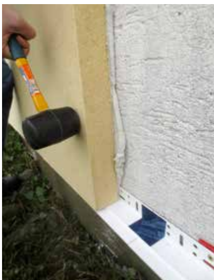
WALL 140 vollflächig auf Sockelschiene aufstellen.
