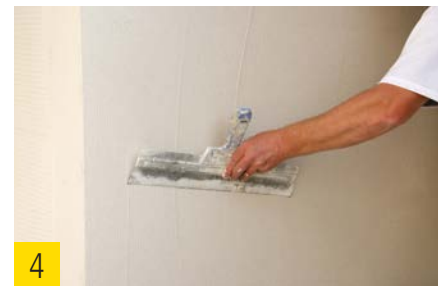
4 best wood Armierungsgewebe eingespachtelt.
