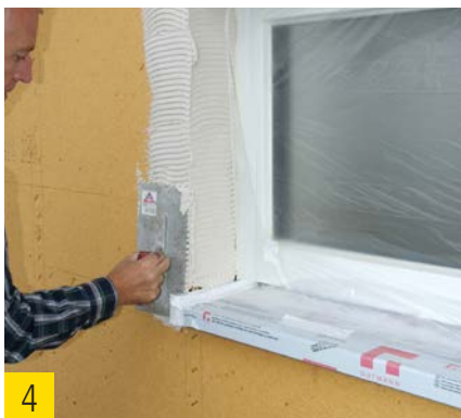
Klebe- und Armierungsmörtel UP in der Fensterlaibung und Außenecke aufbringen.
