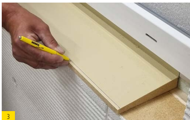
3 Dichtkeil mit entsprechender Tiefe anzeichnen.
