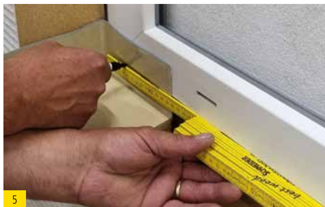
5 Die Lippe der Dichtecken in der Höhe am unteren Fensterrand anzeichnen.
