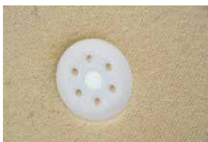
Dämmstoffschraubdübel plan mit best wood WALL 140/180 montiert.
