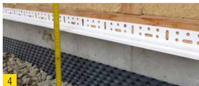
4 Spritzwasserzone \geq 30 cm ohne zusätzliche Maßnahme.
