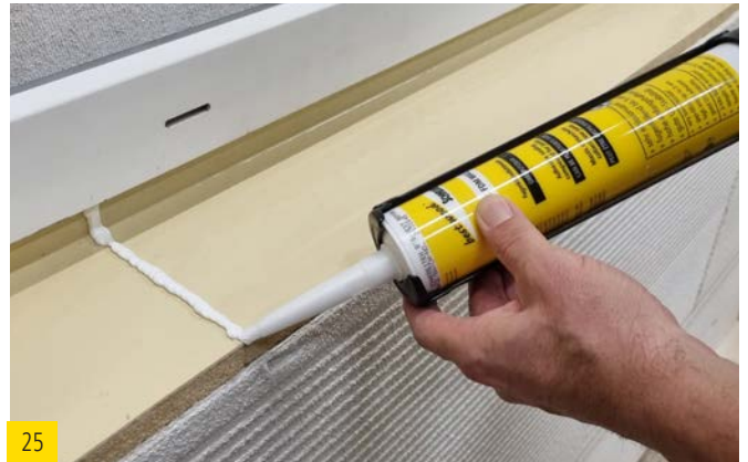
Stoß zwischen Dichtecken und Dichtkeil mit best wood FDM WALL abdichten.
