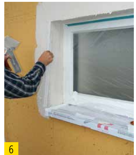
6 Gewebeeckwinkel einsetzen.
