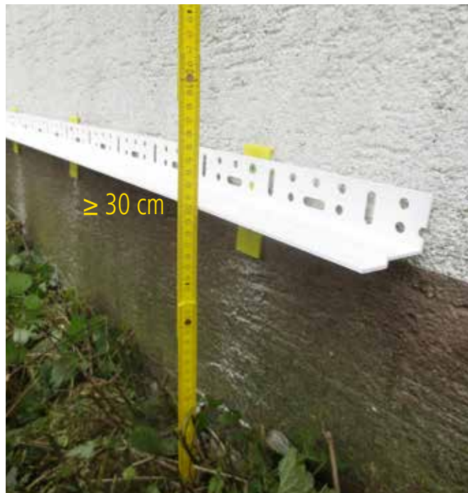
Spritzwasserzone \geq 30 cm ohne zusätzliche Maßnahme.
