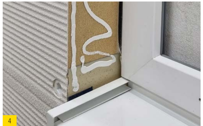
4 best wood FDM WALL seitlich auftragen.
