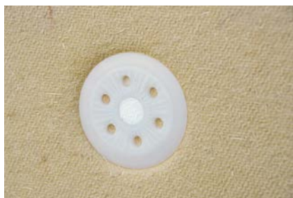
Dämmstoffschraubdübel plan mit best wood WALL 140/180 montiert.
