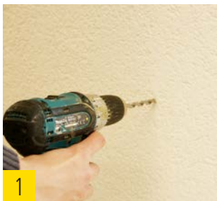
1 Unverputzte Holzfaser-Dämmstoffplatte mit 8 mm-Holzbohrer vorbohren.
