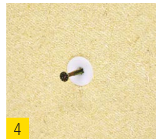
4 Mit 4–5 mm Schraube Anbauteil befestigen.
