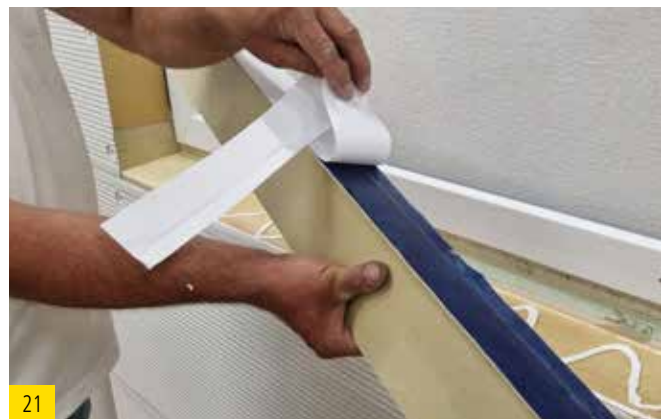
Das Klebeband des bereits zugesägten Dichtkeils abziehen
