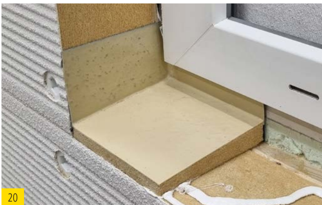
Wichtig: Sicherstellen, dass es zwischen dem Fensterrahmen und der Holzfaserplatte wieder ein "U" bildet (siehe Bild Nr. 10)
