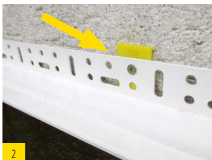
2 Distanzausgleich an Sockelschiene.
