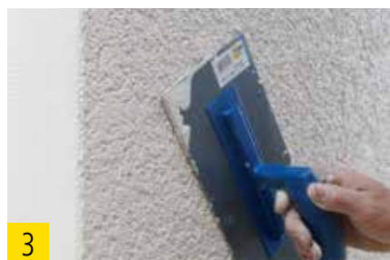
Oberputz mit Traufel strukturieren.
