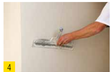
4 best wood Armierungsgewebe eingespachtelt.
