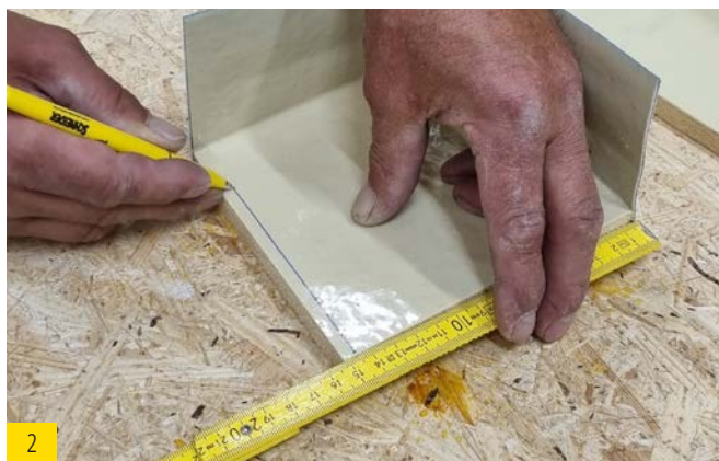
2 Dichtecke mit entsprechender Tiefe anzeichnen.
