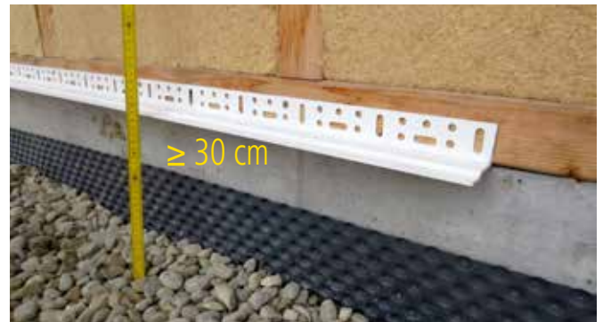
Spritzwasserzone \geq 30 cm ohne zusätzliche Maßnahme.
