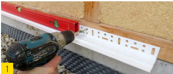
1 Sockelprofil waagrecht ausrichten und befestigen.
