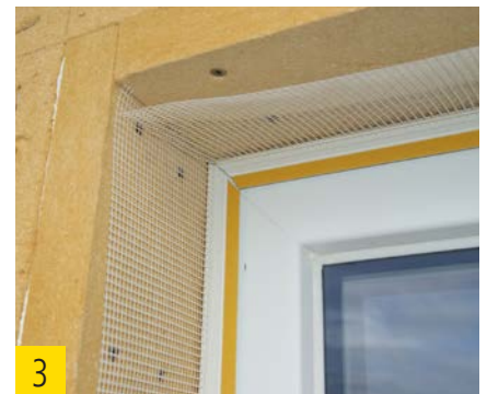
Teleskopanputzleiste in Ecke auf Gehrung geschnitten.
