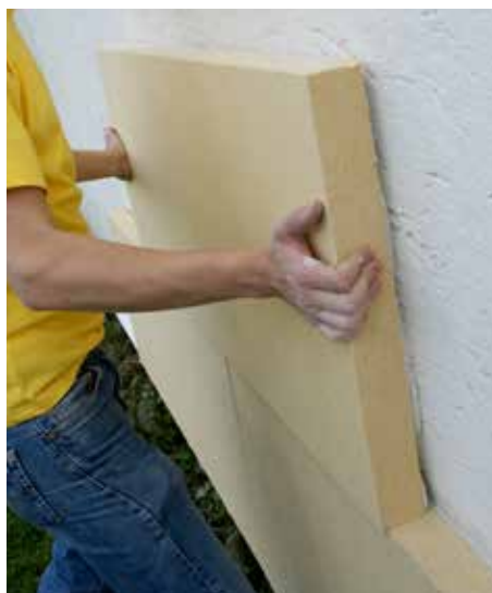
WALL 140 mit schiebenden Bewegungen anbringen.
