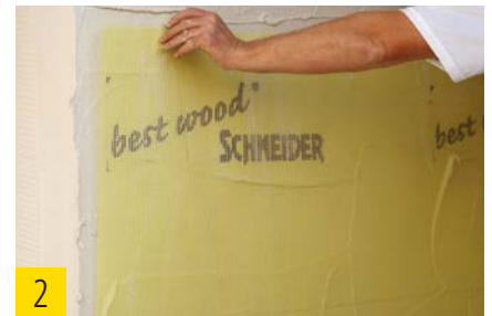
2 best wood Armierungsgewebe einlegen.
