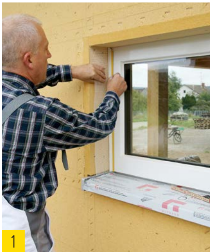
Teleskopanputzleiste ankleben.
