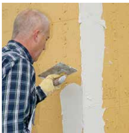
Klebe- und Armierungsmörtel (UP) aufziehen.
