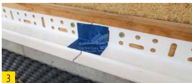
3 Stoß mit Gewebeklebeband abkleben.
