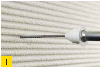
1 Dämmstoff-Schraube H35 (im Zulassungsverfahren) mit best wood Montagetool einbringen.
