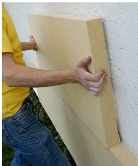
WALL 140 mit schiebenden Bewegungen anbringen.
