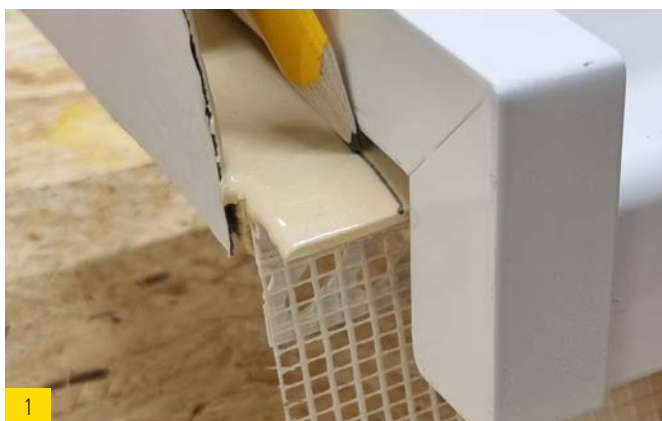
Fensterbanklänge auf rechtem und linkem Dichtkeil anzeichnen.
