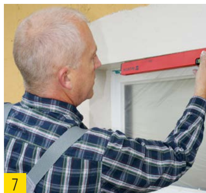
Gewebeeckwinkel horizontal und vertikal ausrichten.
