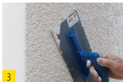
Oberputz mit Traufel strukturieren.
