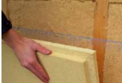
Erste Plattenreihe an waagrechter Schlagschnur ausrichten.
