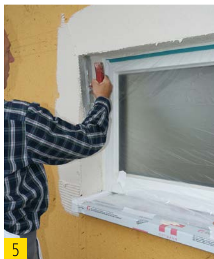
Teleskopanputzleiste einspachteln.
