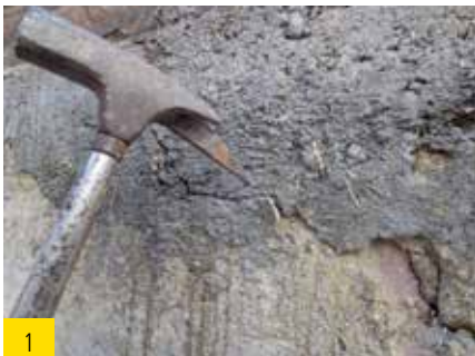
1 Lose Putzschichten entfernen.
