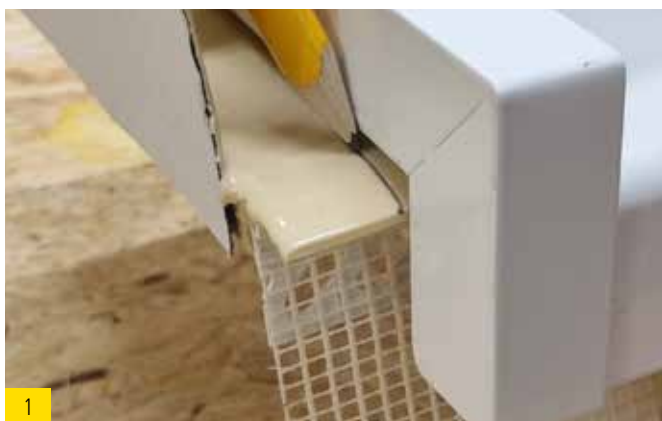
Fensterbanklänge auf rechtem und linkem Dichtkeil anzeichnen.
