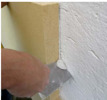
Seitlich austretendem Kleber entfernen.
