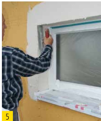
5 Teleskopanputzleiste einspachteln.
