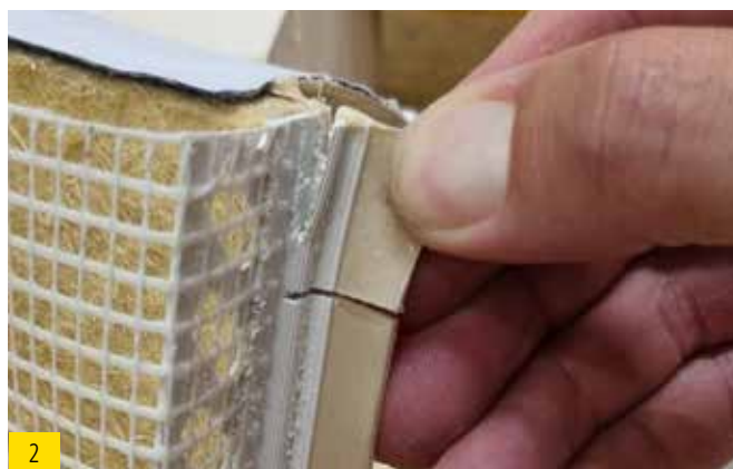
Putzabschlussprofil inkl. Gewebesteg auf angezeichnete Länge kürzen.
