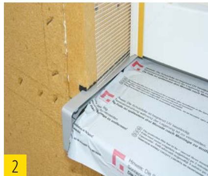
Teleskopanputzleiste bündig mit Innenkante Fensterbankendstück.
