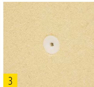
3 Schraubdübel oberflächenbündig montieren.
