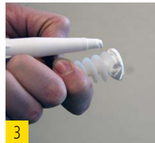
3 best wood FDM WALL zur Abdichtung verwenden.
