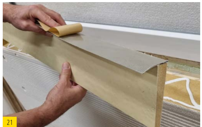
Das Klebeband des bereits zugesägten Dichtkeils abziehen
