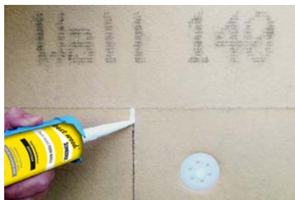
Verlegefugen mit FDM WALL schließen.
