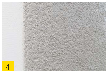
Fertig strukturierte Putzfläche.
