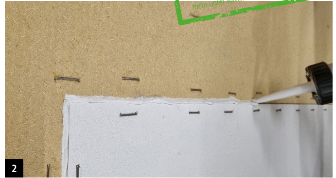
2 Fugen in Fassadenebene mit FDM WALL verschließen
