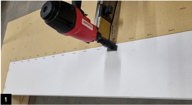
1 STURZBLENDE umlaufend auf halbe Ständer-/ Riegelbreite klammern
