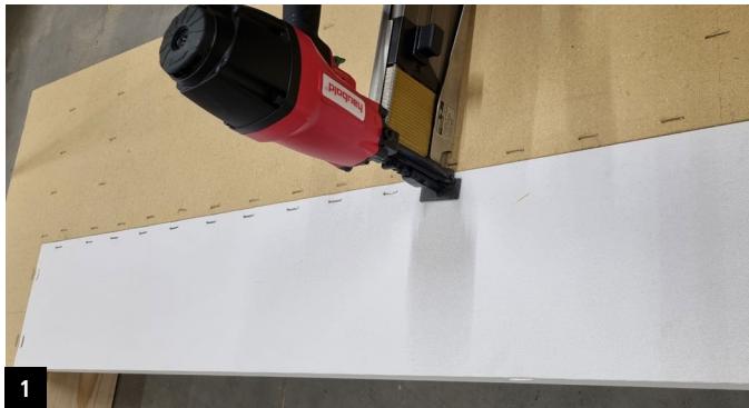
1 STURZBLENDE umlaufend auf halbe Ständer-/ Riegelbreite klammern
