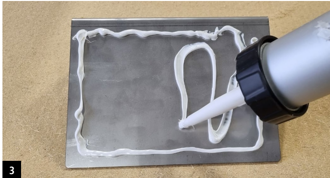
3 FDM WALL auf den Winkel auftragen und rückseitig der STURZBLENDE andrücken (Abstände siehe Verarbeitungsrichtlinie)
