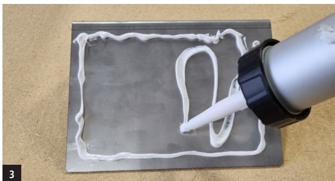
3 Appliquer FDM WALL sur l'équerre et la presser à l'arrière du LAMBREQUIN (pour les distances de mise en œuvre)
