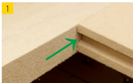
(1) Pour éviter les ponts thermiques dans l'isolant, tous les raccords des panneaux best wood se feront à l'onglet sans écarts ni ouvertures.
