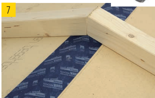
(7) Raccord de faitage étanché et panneaux de fibres de bois fixés par les contre-lattes.
