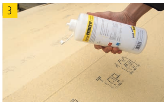
(3) Appliquer le TESCO PRIMER RP à l'aide d'un pinceau (4), ou rouleau synthétique ou avec le système TENAPP (5). Veillez à appliquer le produit sur une bande légèrement plus large que la largeur de l'adhésif utilisé.
