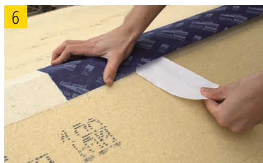
(6) Appliquer la bande adhésive TESCO VANA sur la zone préparée encore humide. Presser fortement et lisser à l'aide de la spatule de fixation PRESSFIX.
