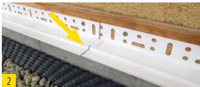
2 Utilisez des languettes d'assemblage pour des joints longitudinaux.
