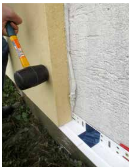
WALL 140 posé sans jeu dans le socle de départ.
