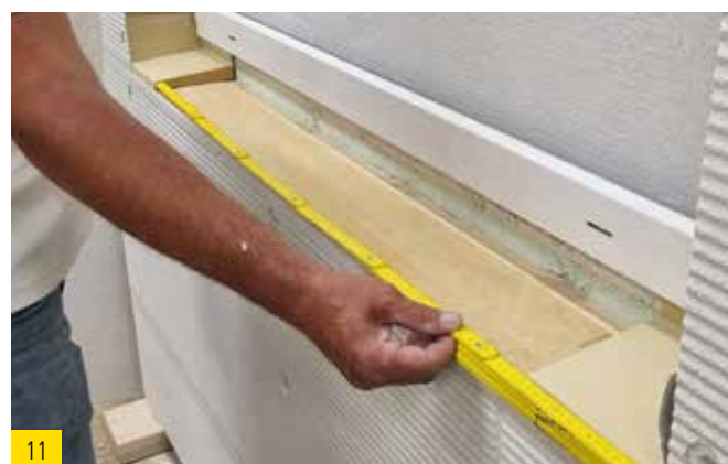
11 Mesurer l'espace entre l'extrémité de cale d'étanchéité gauche et droite et couper la cale d'étanchéité (partie centrale) à la bonne longueur.
