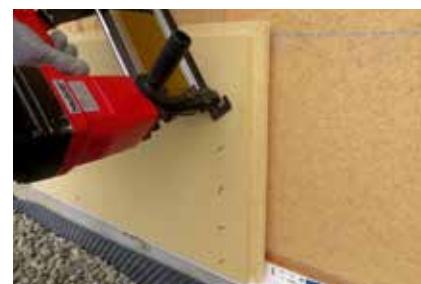
Fixation à l'aide d'agrafes à dos large.
