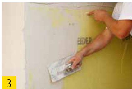
3 Lissage frais sur frais du treillis d'armature.
