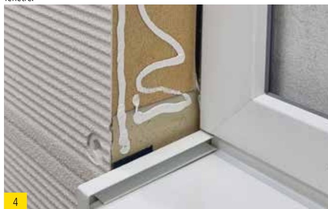
4 Appliquer best wood FDM WALL sur le côté.
