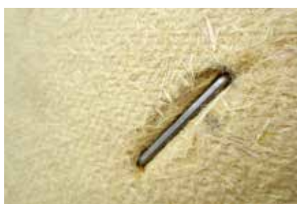
Enfoncer les agrafes à dos large d'env. 1 mm dans le best wood WALL 180.
