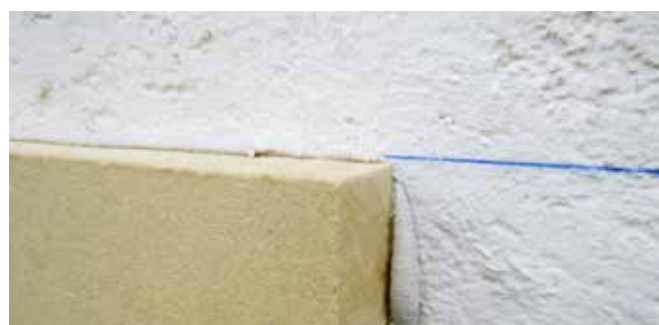
Aligner horizontalement le WALL 140 sur une ficelle.
