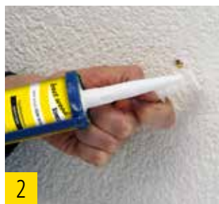
2 Appliquer la masse FDM WALL pour étancher la collerette de la cheville.
