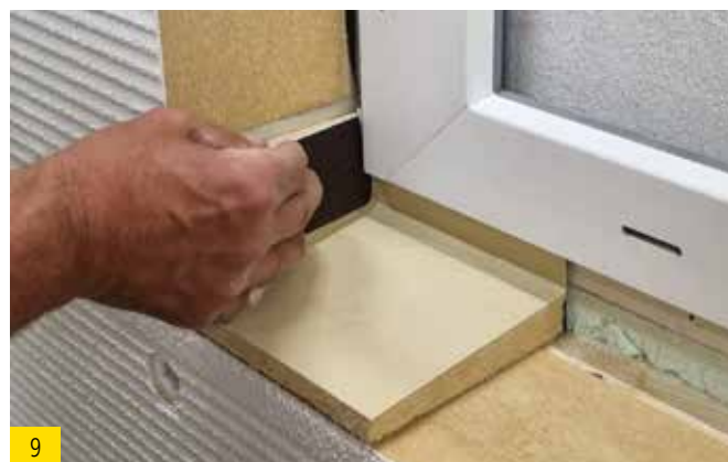
9 Placer les deux extrémités de cale d'étanchéité et les enfoncer proprement dans le coin de la tablette de fenêtre à l'aide d'un accessoire (par exemple une cale en bois).
