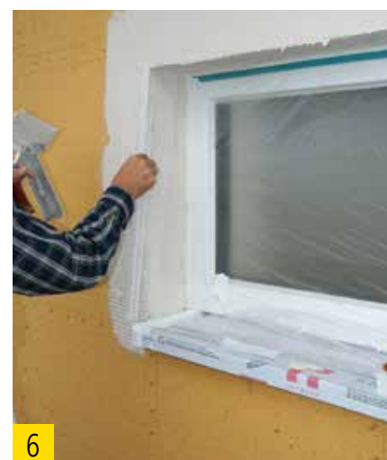
Pose du profil d'angles.
