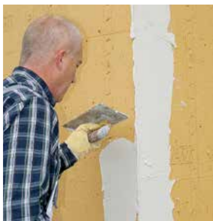
Application du mortier d'enrobage (UP).
