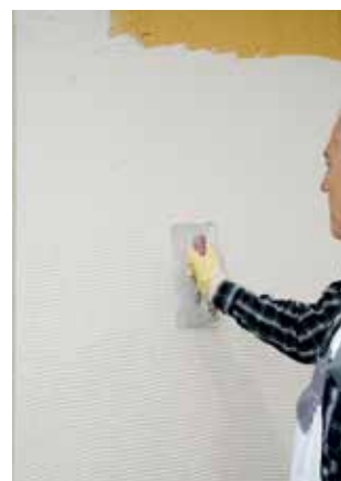
Application à la truelle dentelée.
