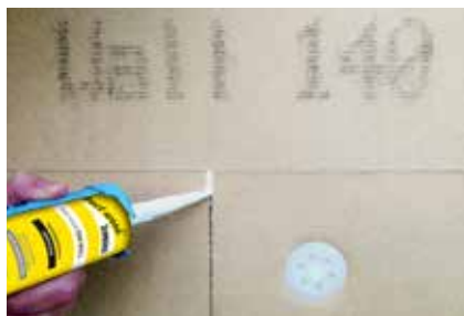
Joints colmatés avec FDM WALL.
