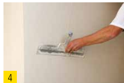
4 Lissage du treillis d'armature.
