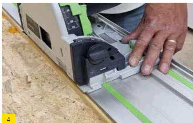
4 Scier la cale d'étanchéité et les deux extrémités de cale d'étanchéité au niveau du bord avant à la profondeur souhaitée.
