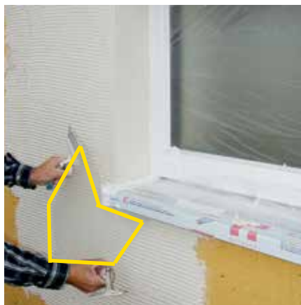
Enrobage à la spatule du coin d'armature.
