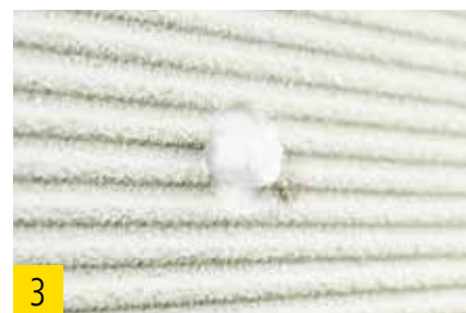
3 Enfoncer les bouchons de fermeture.
