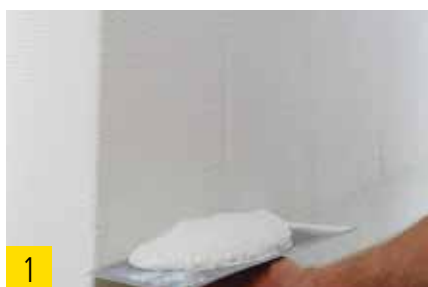
Appliquer le crépi de finition à la truelle et lisser selon le grain.
