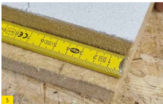
5 Mesurer 40 mm pour l'entaille du coin arrière sur la fenêtre.
