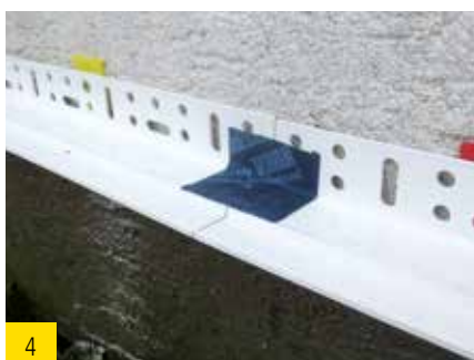
4 Étancher les joints avec une bande collante.
