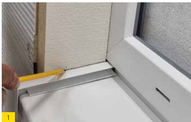
1 Entailler le panneau d'embrasure de 40 mm.
