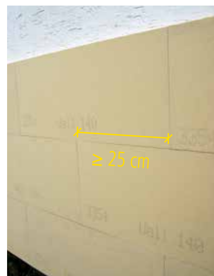
Décalage des panneaux au minimum 25 cm.
