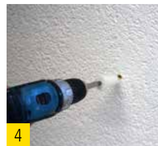
4 Visser la cheville surface à l'aide d'un embout T40.
