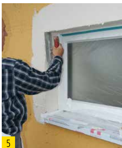
Enrobage à la spatule du profil d'embrasure télescopique.
