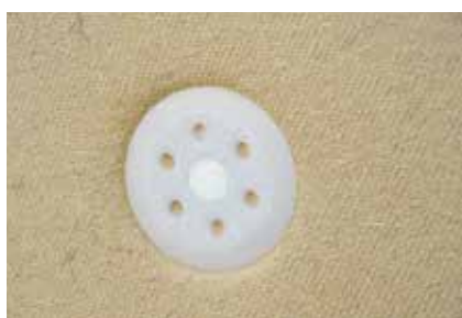
Cheville universelle affleurée sur le panneau WALL 140/180.
