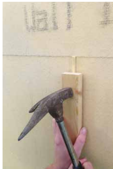
Joints complétés par une bande de panneau WALL 140/180.
