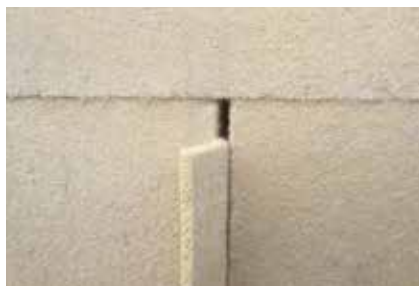
Joints complétés par une bande de panneau WALL 140/180.
