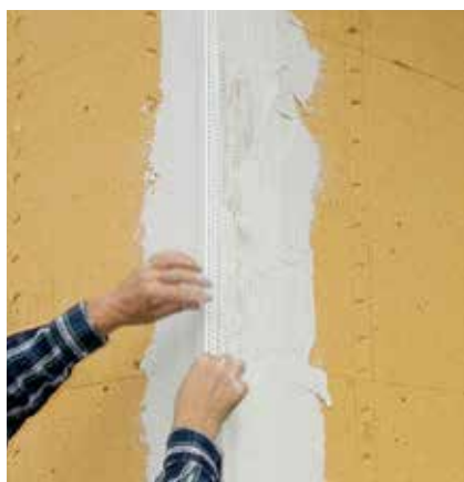
Pose du profil d'angles.
