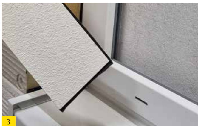
3 Couper le panneau d'embrasure en fonction de la pente de la tablette de fenêtre et appliquer best wood compri-band type 12/3-7 sur le côté court et le côté long.
