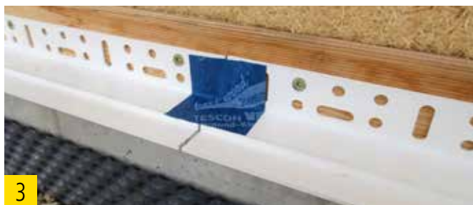
3 Étancher les joints avec une bande collante.
