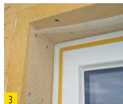
Profil d'embrasure télescopique coupé à l'onglet.
