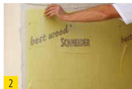
2 Appliquer le treillis d'armature.
