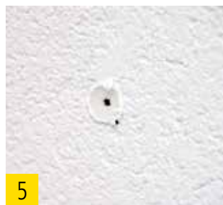
5 Retirer le surplus de masse FDM WALL.
