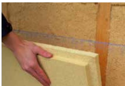
Alignez horizontalement le bord supérieur de la 1 ère rangée de panneaux à l'aide d'une ficelle.
