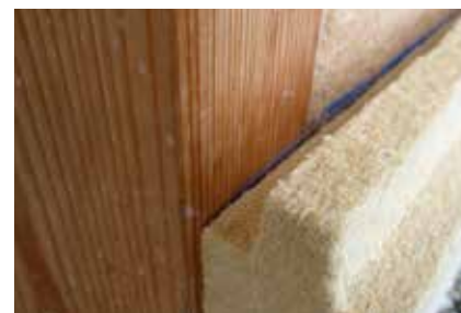
Alignez horizontalement le bord supérieur de la 1 ère rangée de panneaux à l'aide d'une ficelle.
