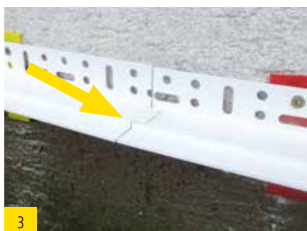
3 Utilisez des languettes d'assemblage pour des joints longitudinaux.
