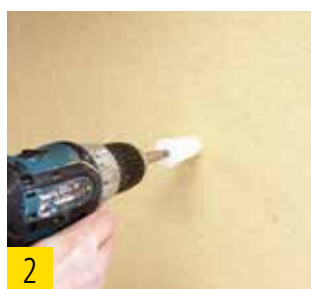
2 Visser la cheville hélicoïdale à l'aide d'un embout T40.
