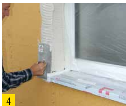
Application du mortier d'enrobage dans l'embrasure et l'angle de façade.
