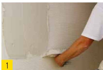
1 Remplissage des rainures.
