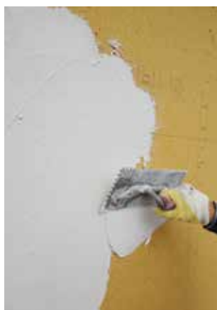
Application de la colle et mortier d'enrobage (UP).
