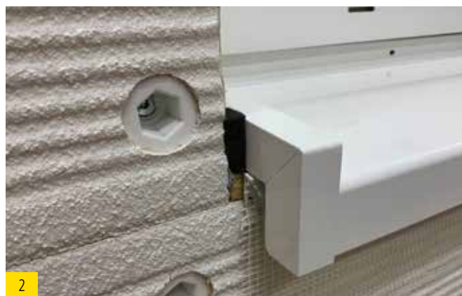
2 Monter la tablette de fenêtre. L'extrémité de la tablette de fenêtre et le profil de finition doivent être alignés. Placer le compri-band sur l'extrémité de la tablette de fenêtre.
