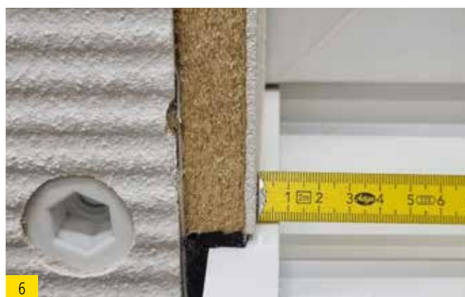
6 La joue de l'extrémité de la tablette de fenêtre doit encore dépasser d'environ 7 mm pour la suite du crépissage. Env. 10 mm pour les panneaux d'embrasure qui ne sont pas pré-enduits.
