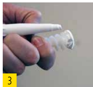
3 Appliquer la masse FDM WALL pour étancher.
