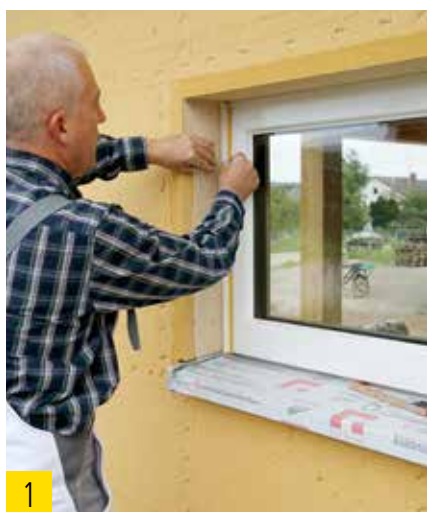
Collage contre le cadre du profil d'embrasure télescopique.
