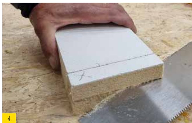
2 Tracer 20 mm et marquer ce qui doit être scié.
