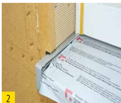
Profil d'embrasure télescopique affleuré avec le bord intérieur de l'about de la tablette du fenêtre.
