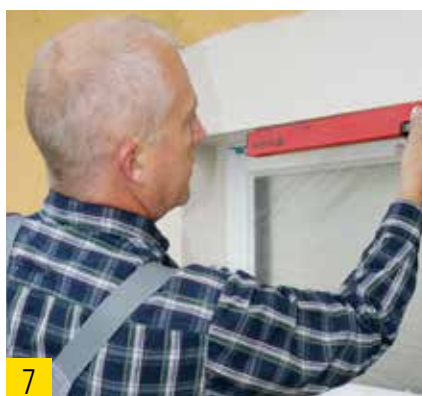
Ajustage des angles d'armature de niveau et d'aplomb.
