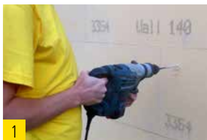
1 Pré perçage avec le perforateur.
