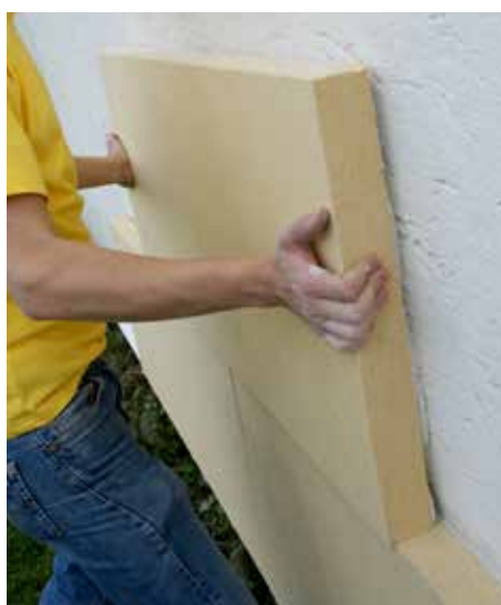
Poser le WALL 140 en appliquant un léger cisaillement contre le support.
