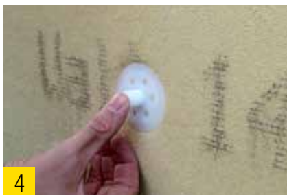
4 Reboucher le manchon avec les bouchons.
