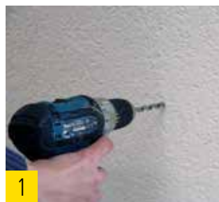
1 Pré perçage du panneau crépi, mèche de 8 mm.
