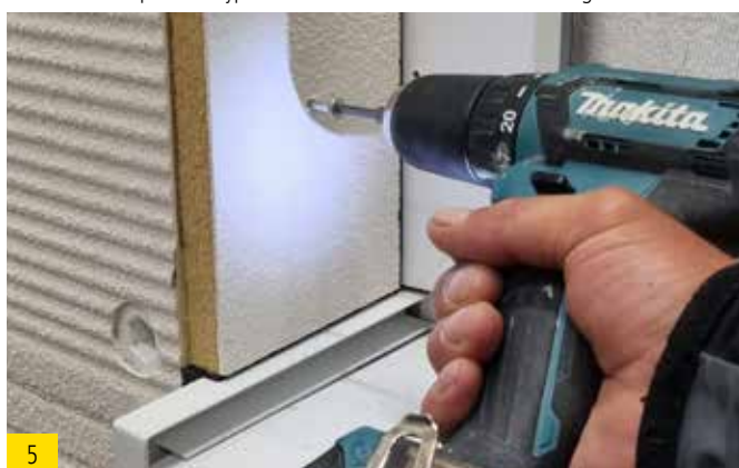
5 Placer le panneau d'embrasure sur la tablette de fenêtre, le presser fermement contre le cadre de fenêtre et le fixer avec des vis inoxydables.
