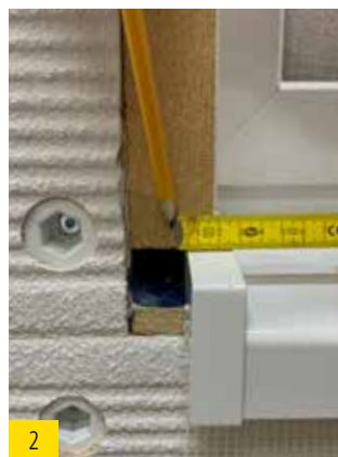
2 Tracer 20 mm et marquer ce qui doit être scié.
