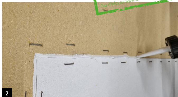
2 Colmater les jointures au niveau de la façade avec FDM WALL
